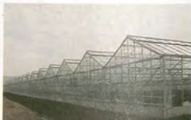
MONTAJ SONRASI GÖRÜNÜŞ
