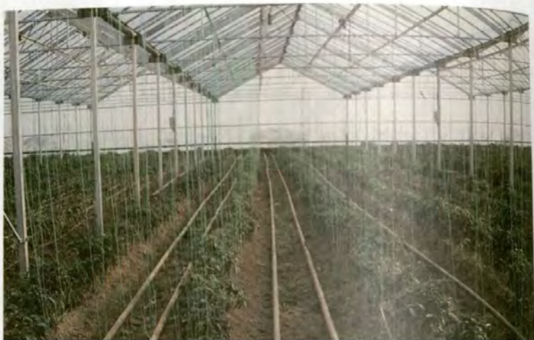
Resim 23: Kurulu Cam Serada Yerden Isıtma Boruları ve Biber Yetiştirilmesi (Ş.Bekişoğlu, Ocak, 2001)
