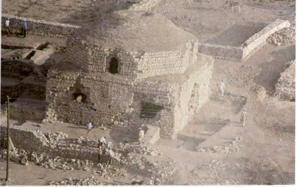
Resim 200: Hamamda çevre düzenlemesi çalışmaları.
