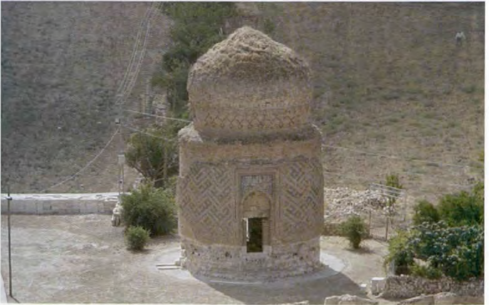
Resim 267: Zeynel Bey Türbesi, 2004 yılında yapılan uygulamanın kaldırılmış hali.
