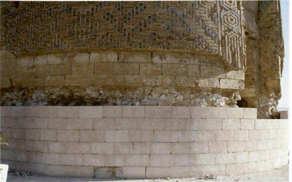
Resim 54: Tübede basit onarım çalışması.
