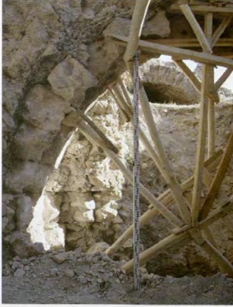
Resim 179: Kemerlerin desteklenmesi
