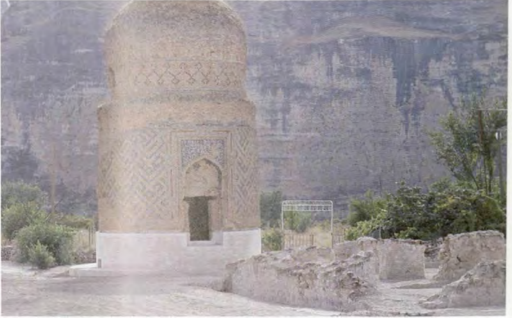
Resim 59: Kısmi onarım sonrası Türbenin kuzeyden görünüşü.
