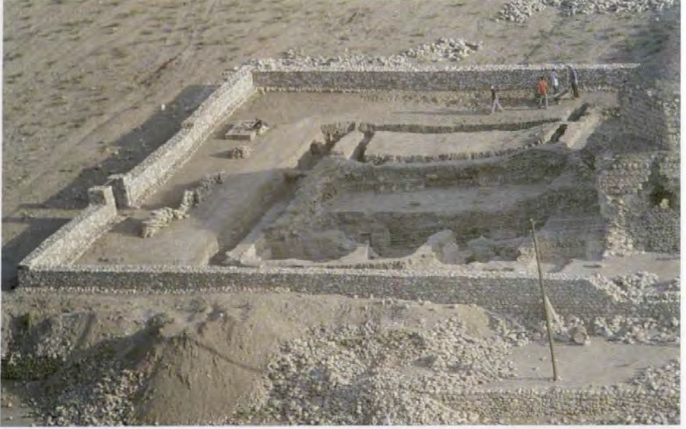
Resim 268: Hamam'da çevre düzenlemesi çalışmaları.
