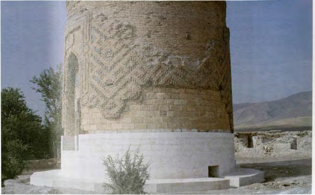
Resim 55: Türbede onarım çalışması, güneydoğudan görünüşü.
