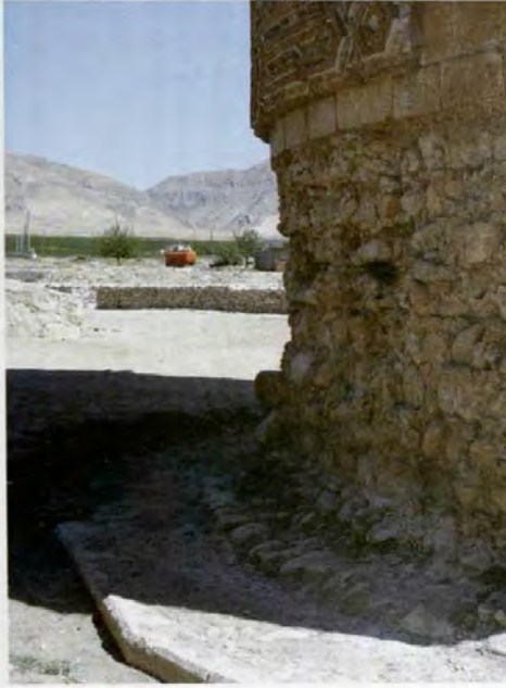
Resim 49: Kuzeybatı Cephede Özgün Kaplama Taşı kap
