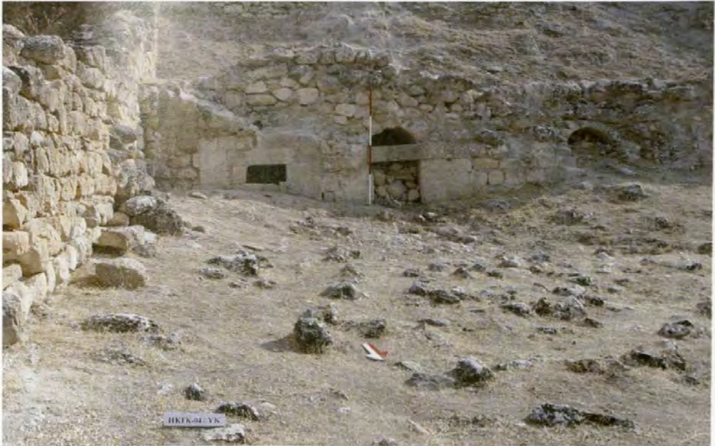
Resim 75: Yamaç Külliyesi, caminin kazı öncesi durumu, doğu kanadı.
