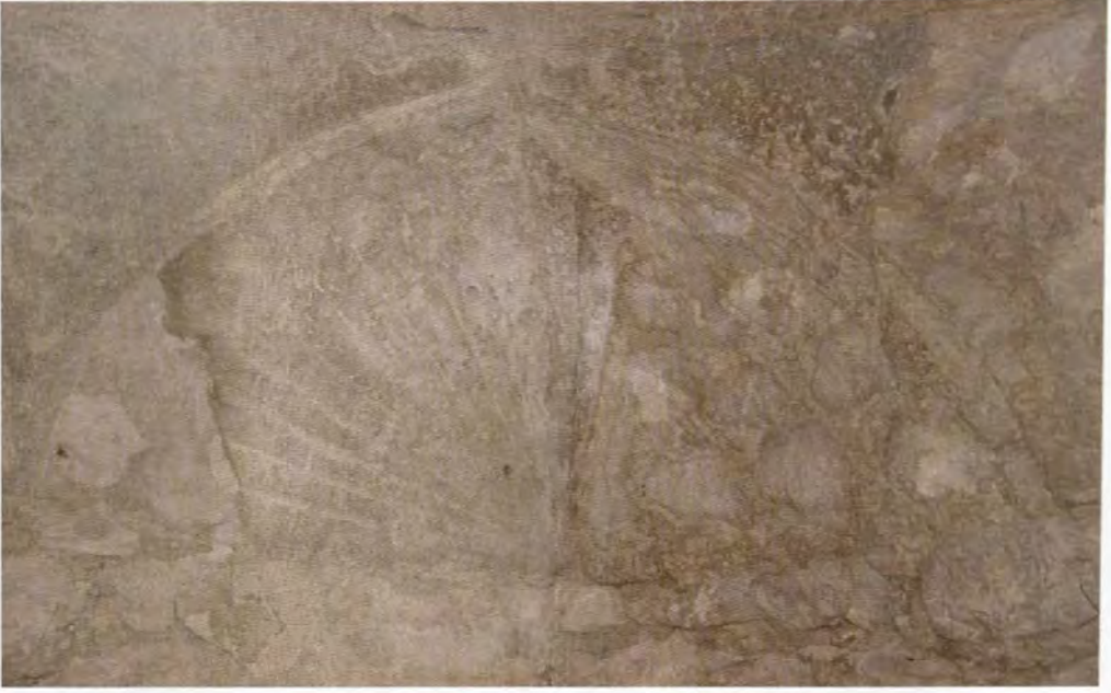
Resim 78: Caminin batısındaki zaviye hücresinin isticriye yivli trompu.
