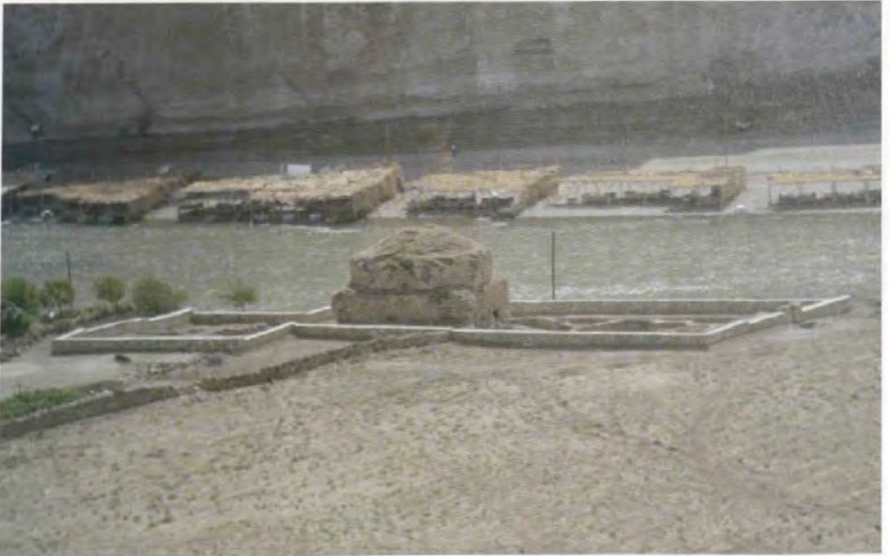
Resim 269: Hamam'da çevre düzenlemesi çalışmaları.
