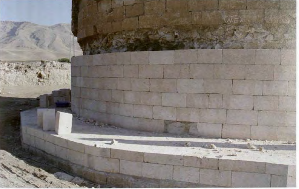
Resim 53: Tübede basit onarım çalışması.
