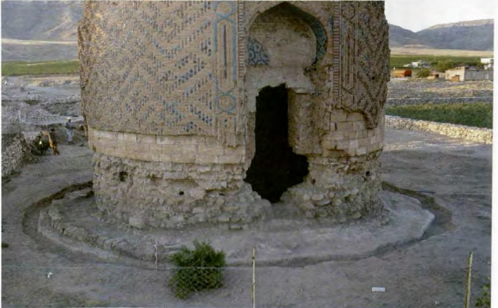
Resim 48: Onaltıgen Alt Platform, Güney Cephe
