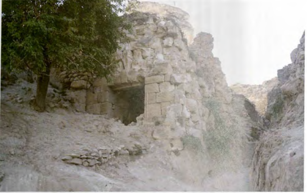
Resim 204: İç Kale girişinde Roma dönemi yapı kalıntısı, İn situ durumu.
