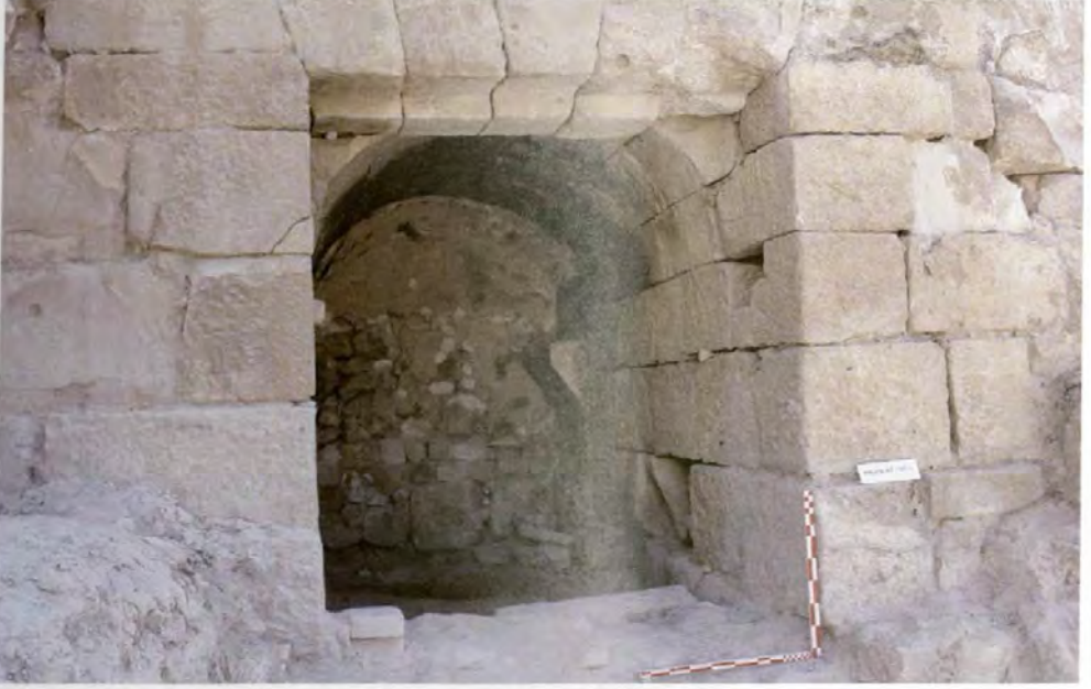
Resim 208: Roma dönemi yapı kalıntısında kazı çalışmaları, ayrıntı.
