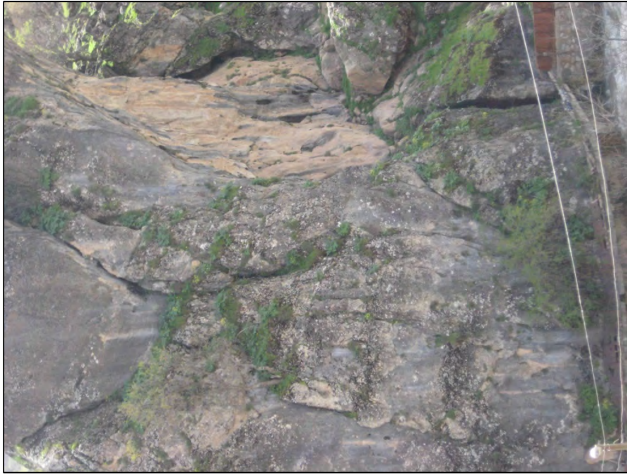
Şekil 16.5: İnceleme alanında Zümrüt Kaplıcası'nın üzerinde yer aldığı karbonatlı zon
