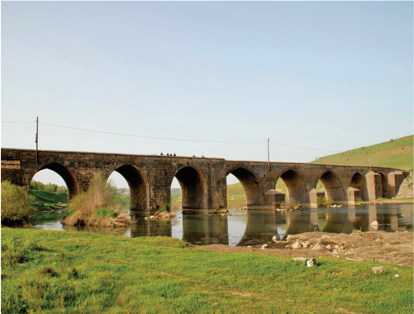
On Gözlü Köprü
