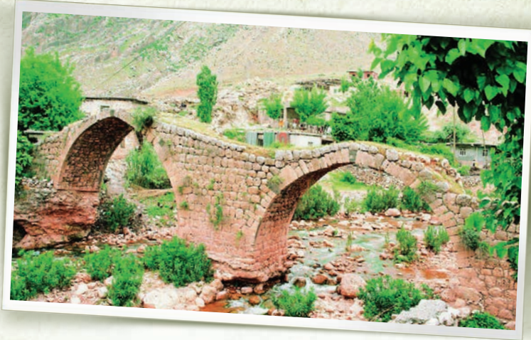
Han Mahmut Köprüsü - Kasrik / ŞİRNAK
