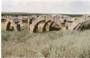
Resim 371 Halfeti Kantarma Mezrası Hanı, Batıdan Görünüm
