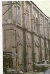
Resim 236 Birecik Belediye Kültür Merkezi Binası, Doğu Cephe
