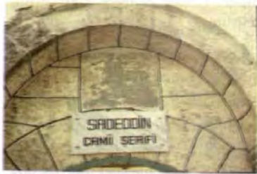
Resim 96 Birecik Şeyh Saadettin Camii, Kuzey Cephe, Kapı Üzerindeki Onarım Kitabesi
