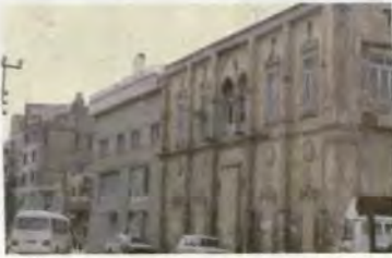
Resim 235 Birecik Belediye Kültür Merkezi Binası, Batı Cephe
