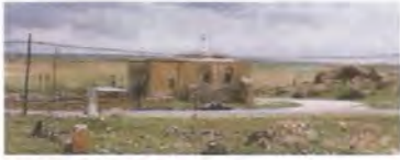
Resim 434 Bozova Büyükhan Köyü Camii, Batı Cephe
