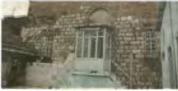
Resim 111 Birecik Sancak Camii, Kuzey Cephe
