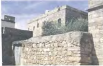
Resim 366 Halfeti Saylakkaya Köyü Camii, İmam Evi, Batı Cephe
