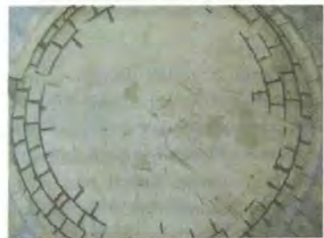
Resim 195 Birecik Şeyh Safi Türbesi, İç Mekan, Kubbe
