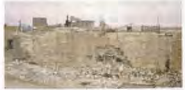
Resim 253 Birecik Bağlar Surları, Doğu Cephe, Güney Bölüm
