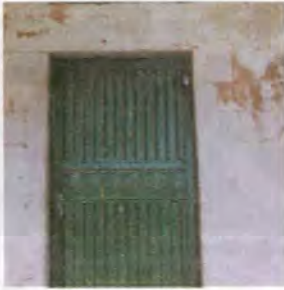
Resim 439 Bozova Büyükhan Köyü Camii, Son Cemaat Yeri, Güney Duvar Ortasındaki Kapı
