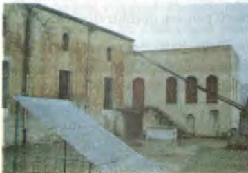
Resim 306 Halfeti Merkez Camii, Batıdan Görünüm
