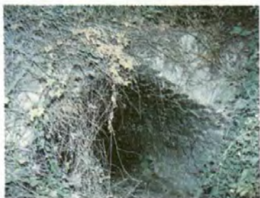
Resim 292 Birecik Zeytinlik Mevkii, Değirmen, Güneye Bakış
