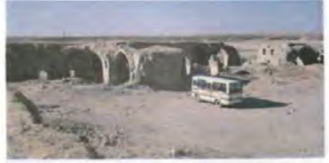
Resim 455 Bozova Büyükhan Köyü Hanı, Avlu, Güneye Bakış
