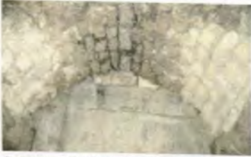
Resim 275 Birecik Meçan Kapı, Giriş Eyvanı, İçten Örtü Sistemi
