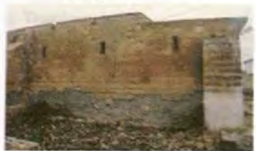
Resim 398 Ziyaret Köyü Şeyh Müslüm Türbesi, Güney Cephe
