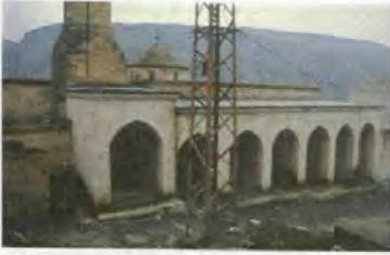
Resim 309 Halfeti Merkez Camii, Doğu Cephe
