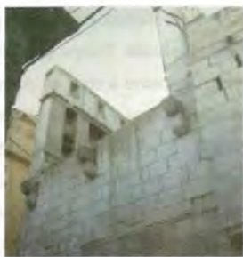
Resim 214 Birecik Turşu Şih Müslim Evi, Doğu Cephe, Taş Konsollar
