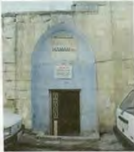
Resim 146 Birecik Mahmut Paşa Hamamı, Kuzey Cephenin Batısı, Kapı
