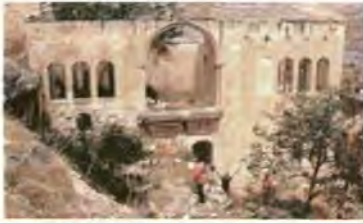
Resim 343 Halfeti Bey Konağı, Selâmlık, Güney Cephe
