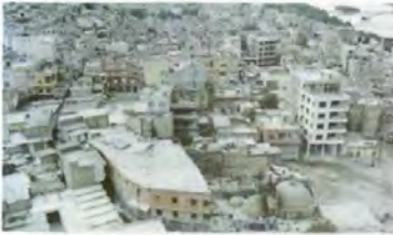
Resim 155 Birecik Hasan Baba Hamamı, Kuzeyden Görünüm
