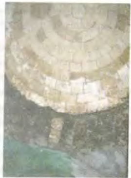
Resim 326 Halfeti Çekem Mahallesi Türbesi, İç Mekân, Kubbe
