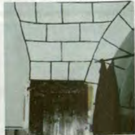
Resim 154 Birecik Küçük Hamam, Sıcaklık, Doğu Eyvan, İlikiğe Açılan Kapı
