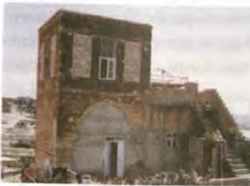
Resim 231 Birecik Osman Demir Evi, Kuzey Cephe
