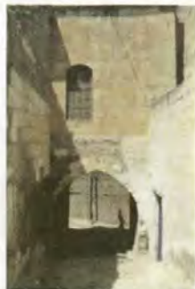
Resim 249 Birecik Karababa Sokağı Kabaltısı, Kuzeyden Görünüm
