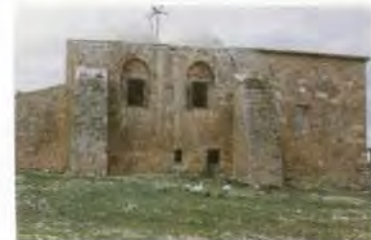
Resim 435 Bozova Büyükhan Köyü Camii, Doğu Cephe
