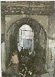
Resim 251 Birecik Kureş ÇıkmaZI Kabaltısı, Örtü sistemi
