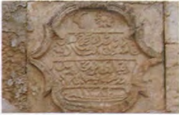
Resim 392 Ziyaret Köyü Şeyh Müslüm Türbesi, Kuzey Cephe, Batı Köşedeki Onarım Kitabesi
