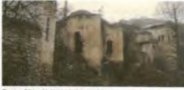
Resim 331 Halfeti Lâtifzade Hamamı, Batı Cephe, Kuzey Bölüm
