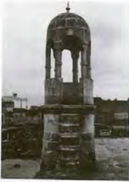
Resim 390 Suruç Ahmed-i Bican Camii, Minare, Doğudan Görünüm
