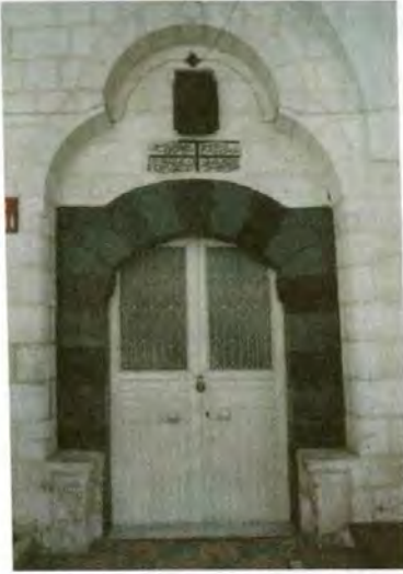
Resim 10 Birecik Ulu Camii, Son Cemaat Yeri Güney Duvarındaki Ana Kapı
