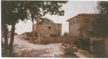
Resim 196 Birecik Şeyh Hasan Baba Türbesi, Kuzey Cephe, Güneydoğudan Görünüm
