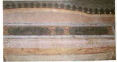
Resim 353 Halfeti Hamamlı Ev, Başoda, Kuzey Duvar, İnşa Kitabesi
