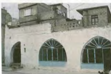
Resim 84 Birecik Abd-i Kethüda Camii, Avlu, Kuzey Kanat, Son Cemaat Yeri Güney Cephesi
