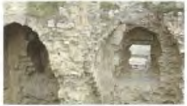
Resim 179 Birecik Şeyh Müftah Türbesi, Batı Bölüm, Güneyden Görünüm
