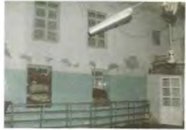
Resim 59 Birecik Mahmut Paşa Camii, İbadet Mekanı, Kuzey Duvarın Batısına Bakış
