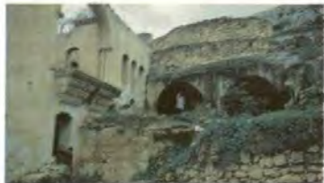
Resim 339 Halfeti Bey Konağı, Kuzeydoğudan Görünüm
