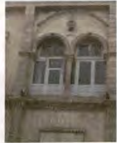
Resim 237 Birecik Belediye Kültür Merkezi Binası, Batı Cephe, Üst Kat, Orta Bölüm
