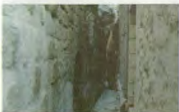
Resim 73 Birecik Eski Mağara Camii ile Yeni Mağara Camii Arasındaki Bölüm, Doğuya Bakış
