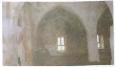
Resim 440 Bozova Büyükhan Köyü Camii, İbadet Mekânı, Doğuya Bakış
