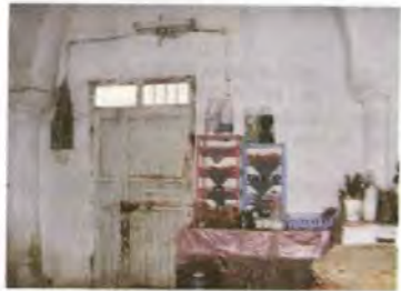
Resim 232 Birecik Osman Demir Evi, Orta Kat, Eyvan, Batı Duvar
