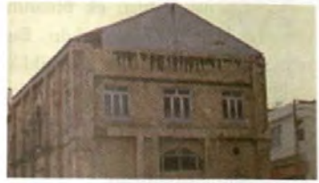
Resim 239 Birecik Belediye Kültür Merkezi Binası, Kuzey Cephe
