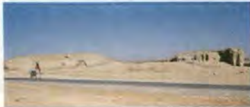
Resim 449 Bozova Büyükhan Köyü Hani, Batı Cephe
