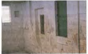
Resim 438 Bozova Büyükhan Köyü Camii, Son Cemaat Yeri, Güney Duvarın Batısı
