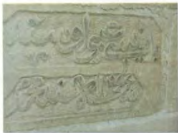
Resim 108 Birecik Sancak Camii, Kuzey Cephe, Kapı Üzerinde Batıdaki Onarım Kitabesi
