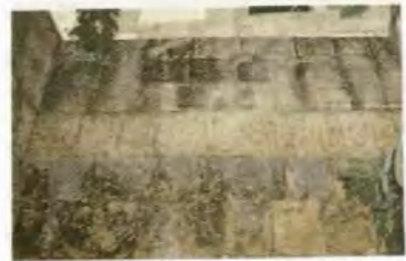
Resim 273 Birecik Meçan Kapı, Güney Duvar
