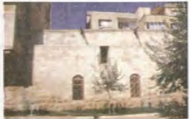
Resim 62 Birecik Tekke Camii, Güney Cephe
