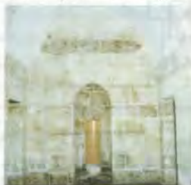
Resim 127 Birecik Alaburç Mescidi, İç Mekan, Güney Duvar
