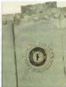
Resim 350 Halfeti Muhittin Ganneci Evi, Batı Cephe, Ayrıntı
