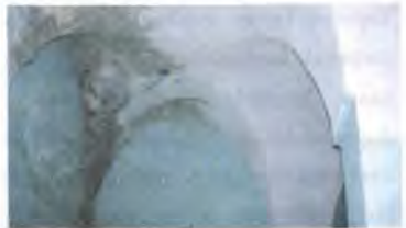
Resim 368 Halfeti Saylakkaya Köyü Camii, İç Mekan, Örtü Sistemi
