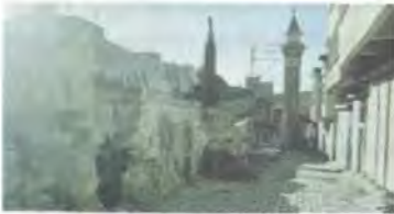
Res. 143 Birecik Mahmut Paşa Hamamı, Kuzey Cephe
