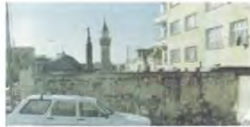
Res. 144 Birecik Mahmut Paşa Hamamı, Doğu Cephe
