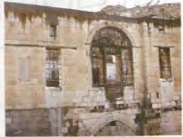
Resim 139 Birecik Sabunhane, Batı Cephe, Üst Kat
