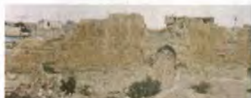
Resim 255 Birecik Bağlar Surları, Doğu Cephe, Orta Bölüm
