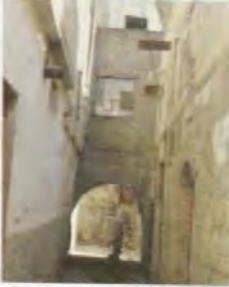
Resim 244 Birecik Mirkelâm Sokağı Kabaltısı, Batıdan Görünüm
