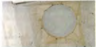
Resim 126 Birecik Alaburç Mescidi, İç Mekan, Kuzeybatı Köşe Mekanı, Örtü Sistemi
