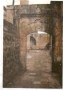
Resim 384 Suruç Ulu Camii ve Medresesi, Güneybatıdaki Kapı
