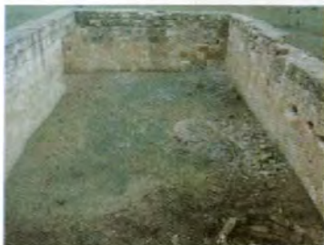
Resim 410 Suruç, Karadut Köyü Değirmeni, İçten Kuzeye Bakış
