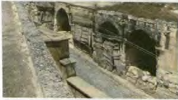
Resim 310 Halfeti Merkez Camii, Kuzeydeki Dükânlar
