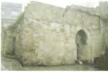
Resim 277 Birecik Meçan Kapı, Kuzeybatıdan Görünüm
