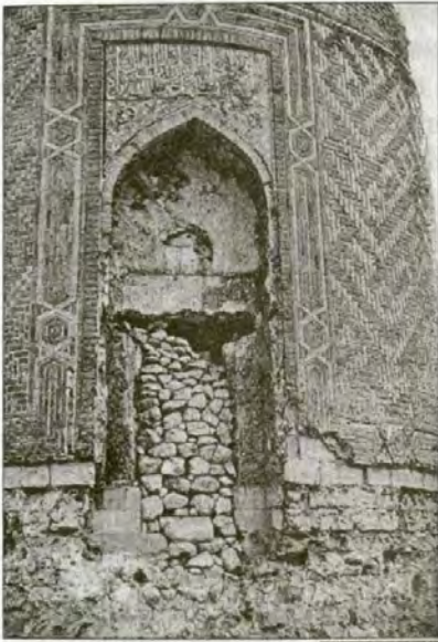
Zeynel Bey Türbesi (Giriş Kapısı ve Kitabesi)
