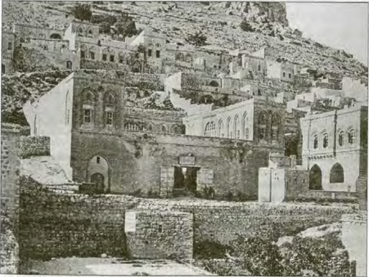
Bugünkü PTT Binası (Gabriel'den 1932)
