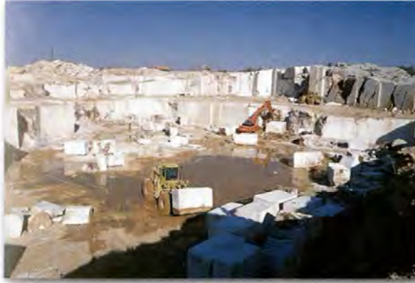
Şekil 10. Diyarbakır yöresinde blok mermer üretimi yapan bir ocak
