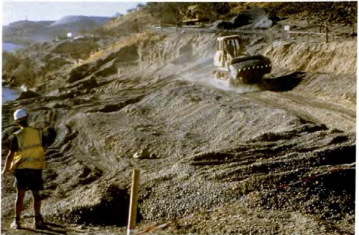
Açmaların iş makinesiyle kapatılması
