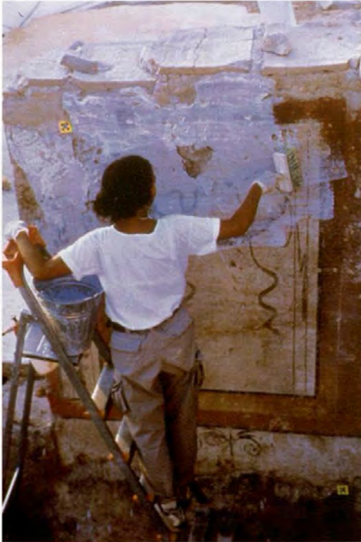
Duvar resimlerinin sağlamlaştırılması
