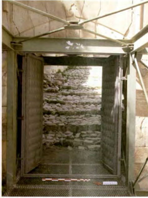
Resim 160: Kale Kapsı'na takılan demir kapı
