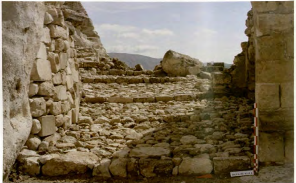
Resim 155: Kale'de gezi yolu çalışmaları
