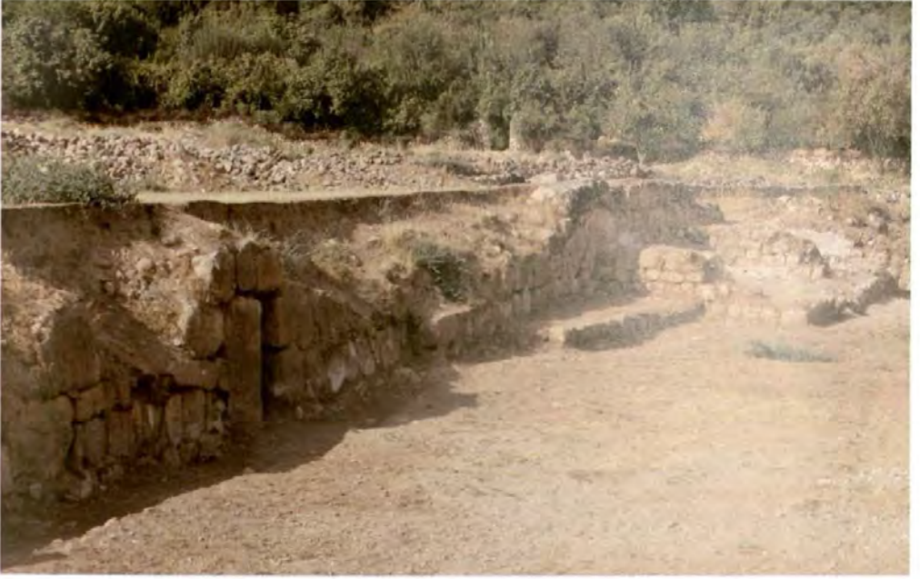
Resim 41: Antik Su Kanalı Ağzı'nın bulunduğu duvar cephesi
