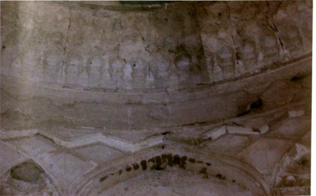
Resim 352: Kubbe tamburunu kaplayan alçı kaplamalar
