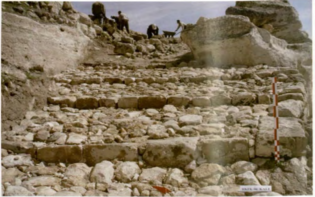
Resim 154: Kale'de gezi yolu çalışmaları
