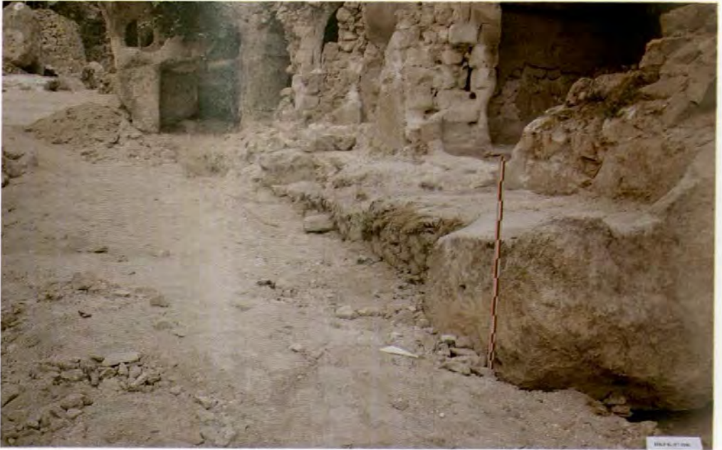
Resim 319: Basit onarım öncesi 12, 14 ve 16 No'lu dükkanlar
