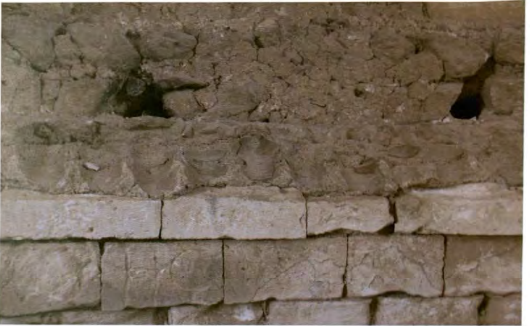
Resim 375: İ cephede oluřan derin ařınma
