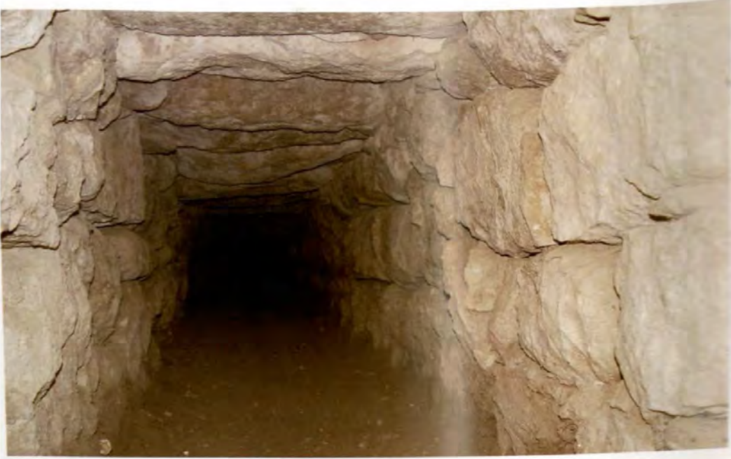
Resim 39: Kasımiye'de Antik Dnem su kanalının iinden grnř
