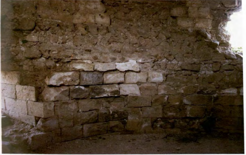
Resim 369: İç mekandaki is tabakaları
