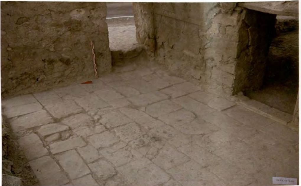
Resim 96: Mescidin son cemaat yeri ve zemin döşemesi
