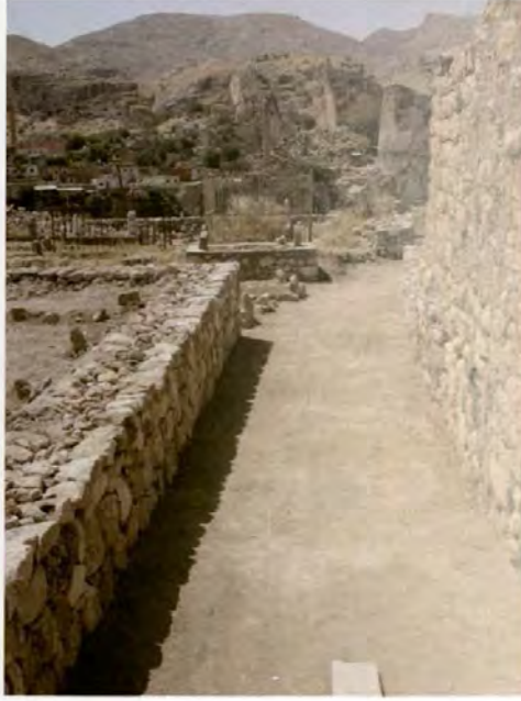
Resim 69: Türebeye geçilen yolun yeniden yapımı
