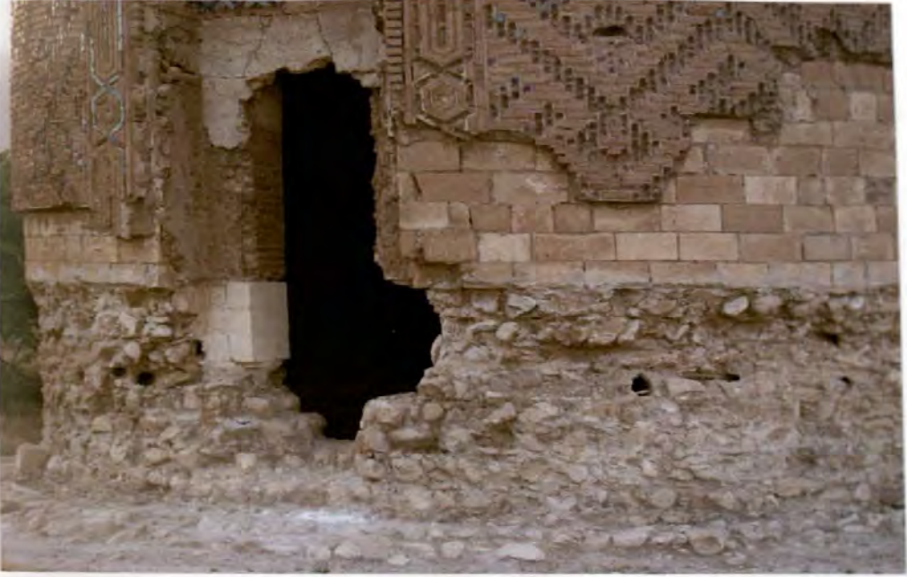
Resim 361: Yapının oturtmalık kısmı
