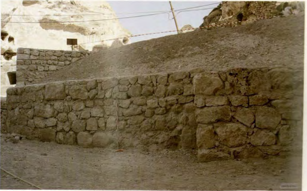
Resim 263: Basit onarım sonrası sur kalıntısı
