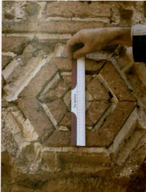
Resim 356: Tuğla derzlerindeki beyaz harç
