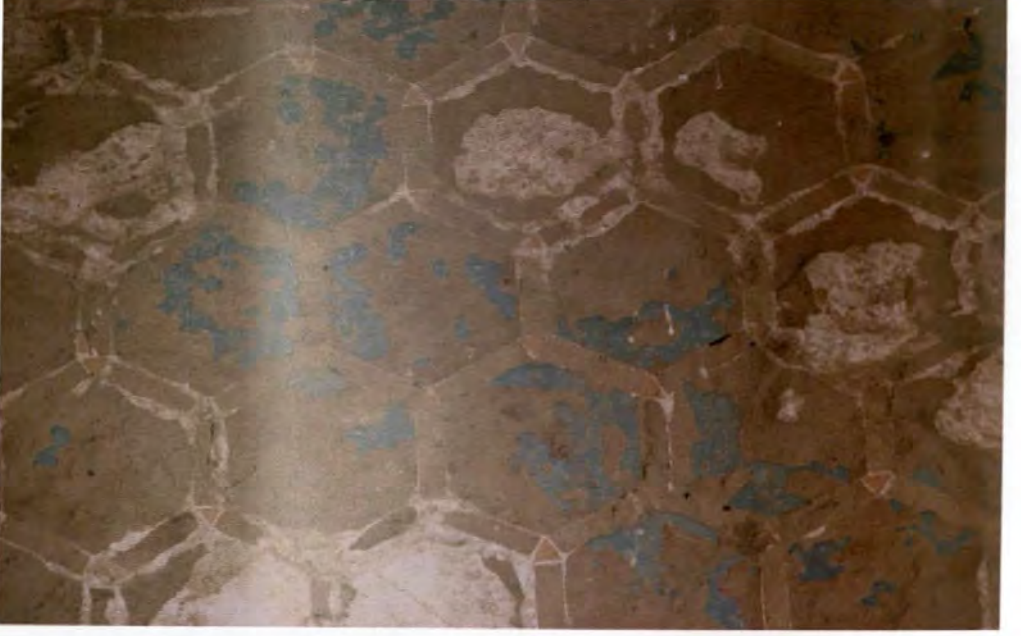
Resim 347: İç yüzeyde kullanılan turkuaz altıgen tuğlalar
