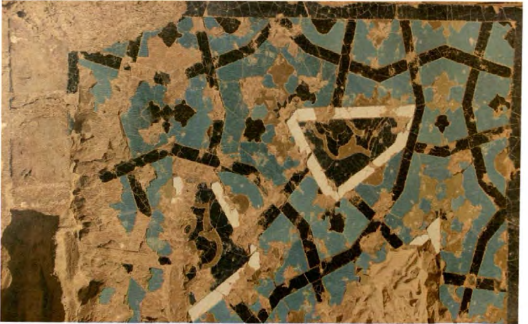
Resim 376: Dıř cephede oluřan yzeysel ařınma
