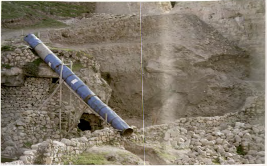
Resim 138: Toprak boşaltma çalışmaları
