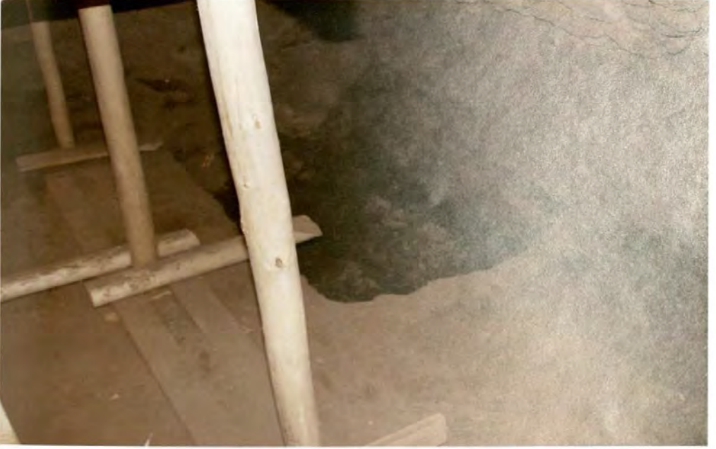
Resim 89: Tonozlu mekanda sağlamlaştırma çalışması
