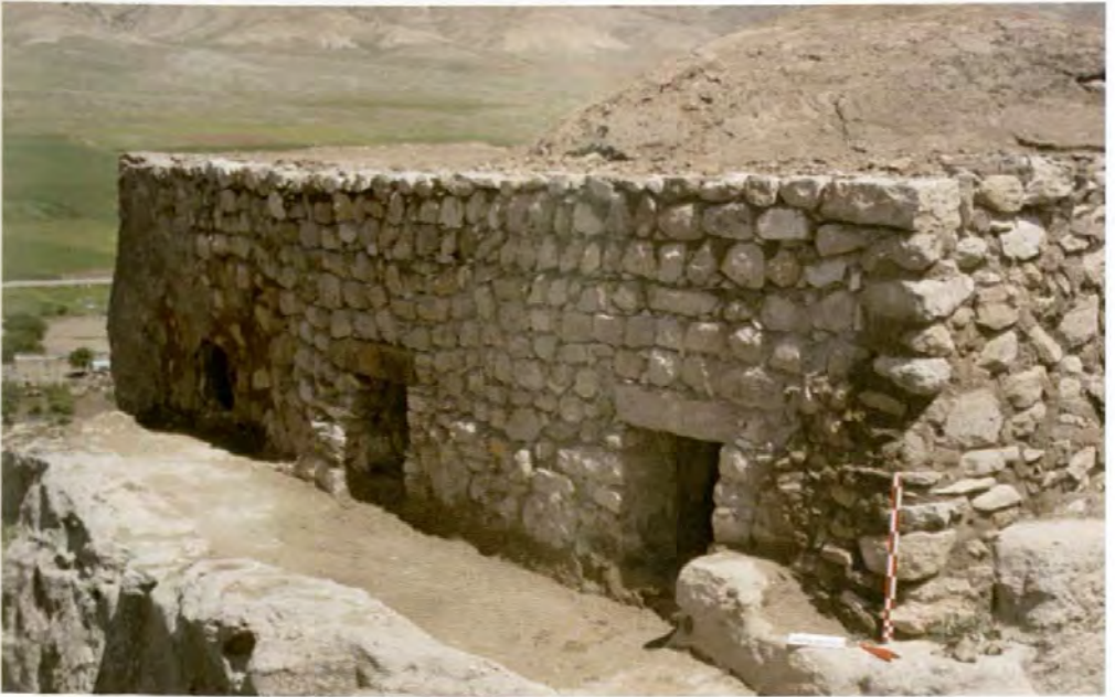
Resim 157: İç Kale Mescidin batı duvarı, basit onarım sonrası
