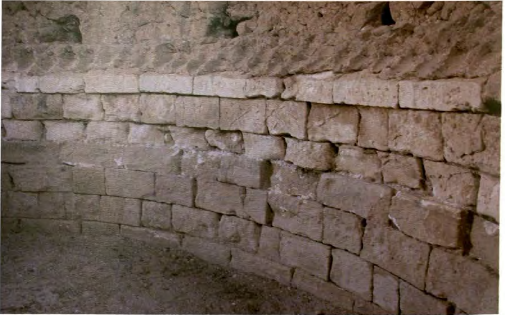
Resim 344: Türbenin iç cephe duvarı
