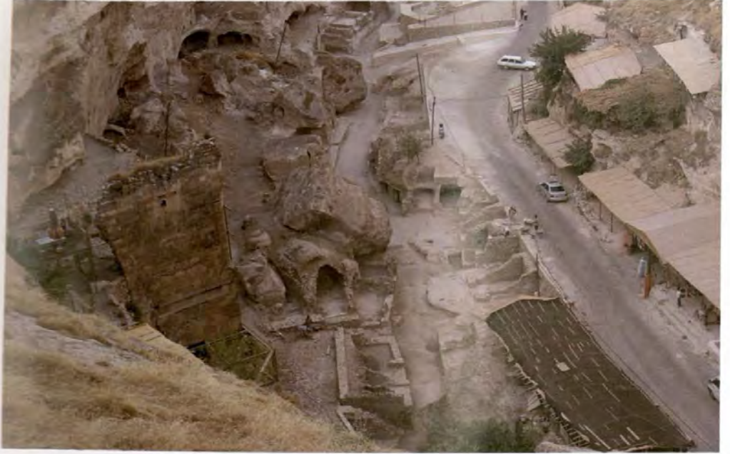
Resim 324: Basit onarım sonrası dükkânlar
