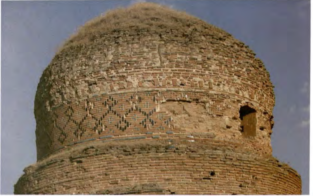
Resim 379: Örtü sisteminde gelişmiş bitki oluşumları
