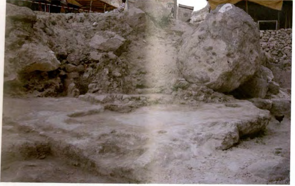
Resim 244: 15 ve 17 No'lu dükkanların insitu durumu
