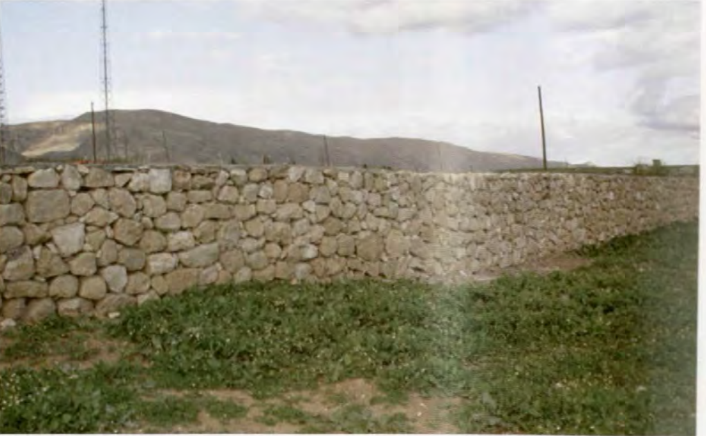
Resim 163: Zeynel Bey Külliyesi'nde yıkılan avlu duvarının onarımı
