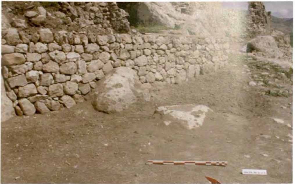
Resim 153: İç Kale'de gezi yolu onarım çalışmaları
