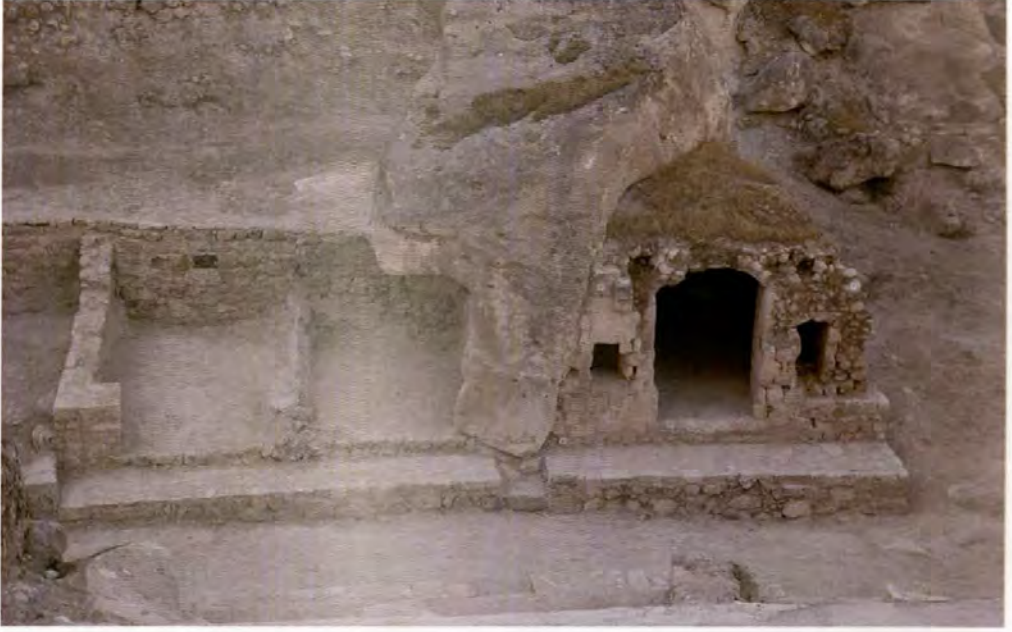
Resim 322: Basit onarım sonrası 08, 40 ve 42 No'lu dükkânlar
