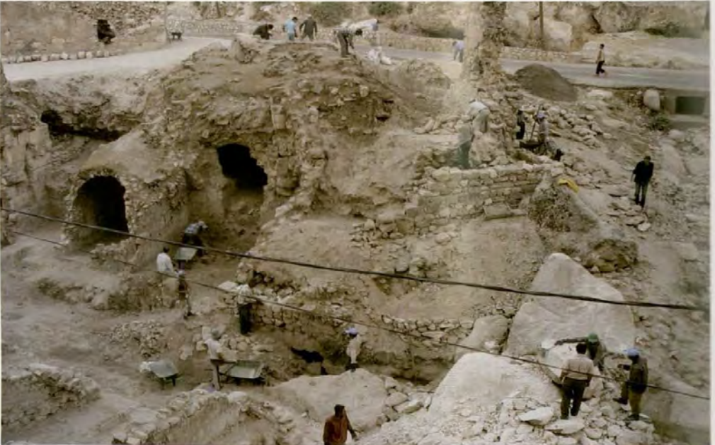
Resim 108: Şâb Camii batusına istinat duvarları örülmesi
