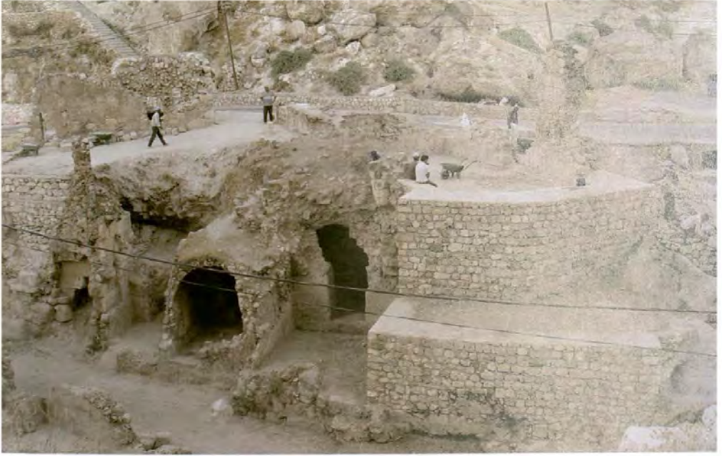
Resim 109: Şâb Camii batısına yapılan istinat duvarları
