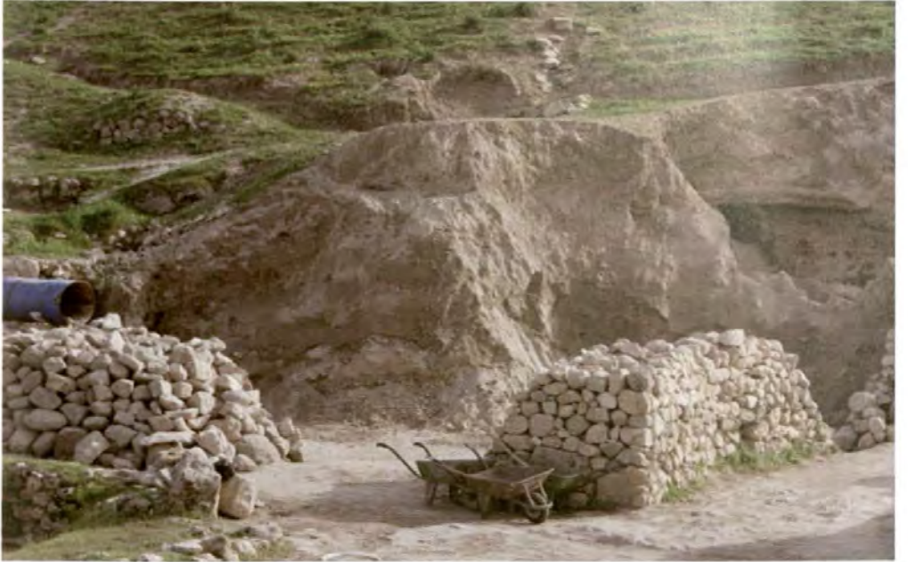
Resim 137: Toprak boşaltma çalışmaları
