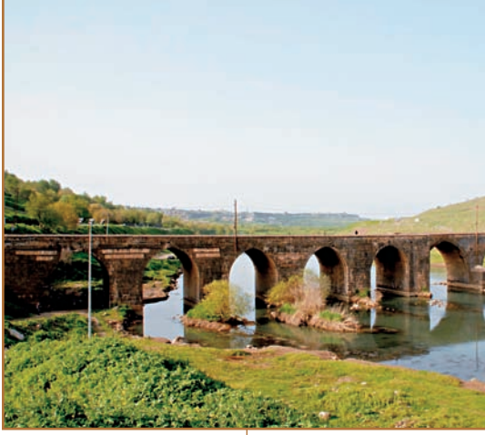
Dicle (on gözlü) Köprüsü
