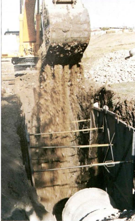
Altyapı Çalışması (kanalizasyon)
