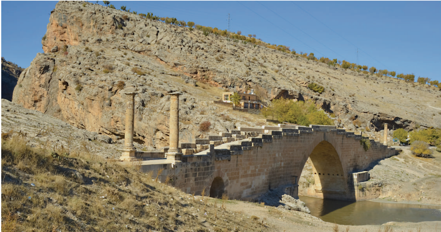
MS 3. yüzyıl başlarında Romalılar tarafından inşa edilen Cendere (Septimus Severus) Köprüsü halen sapaşajlam ayakta. —
