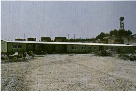
Belkis Köyü'nde GAP İdaresi'nce yaptırılan Jandarma Karakol binası
