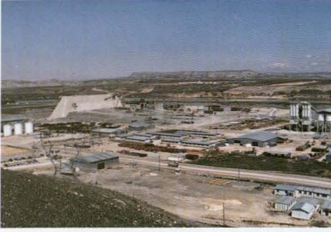
Birecik Barajı İnşaatı
