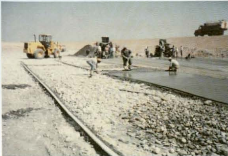
Akçakale Pissu Arıtma İkmal İnşaatı 1 No.lu Ştabilizasyon Havuzu Grobeton Çalışması
