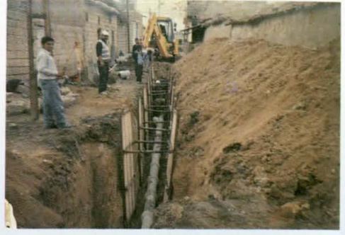
Ceylanpınar Kanalizasyon ve Pissu Arıtma Tesisi İnşaatı
