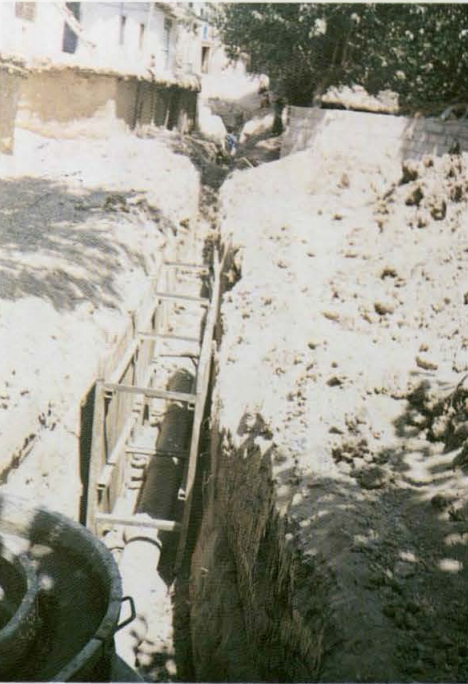
Kahta Kanalizasyon İnşaatı
