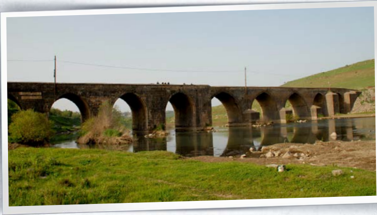
On Gözlü Köprü
