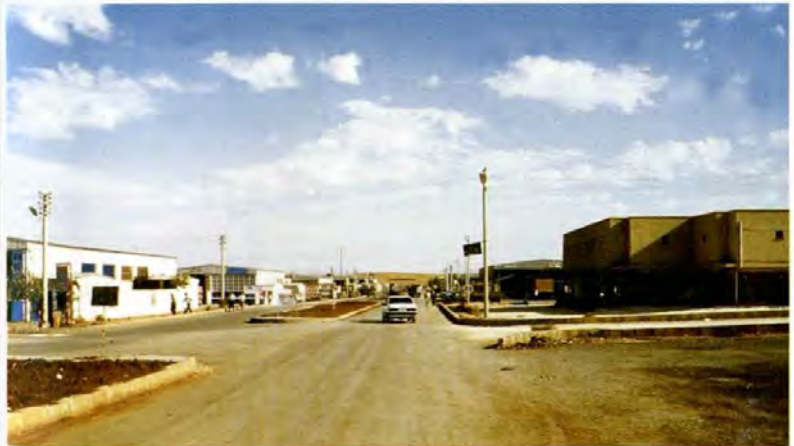
Şanlıurfa Evren Küçük Sanayi Sitesi
