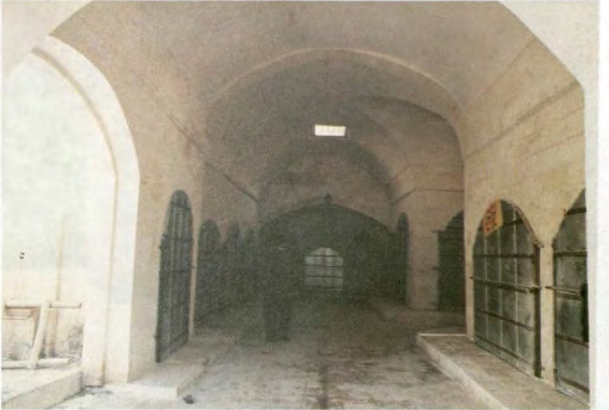
Resim 6 : Sipahi Pazarı Restorasyon sonrası (Temmuz 1997)
