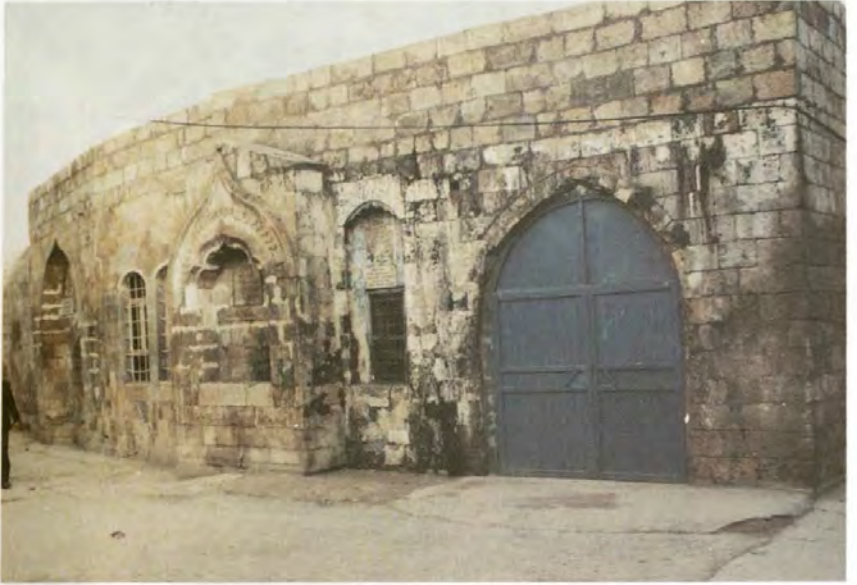
Resim 3 : Şeyh Saffet Çeşmesi ve Türbesi Restorasyon öncesi
