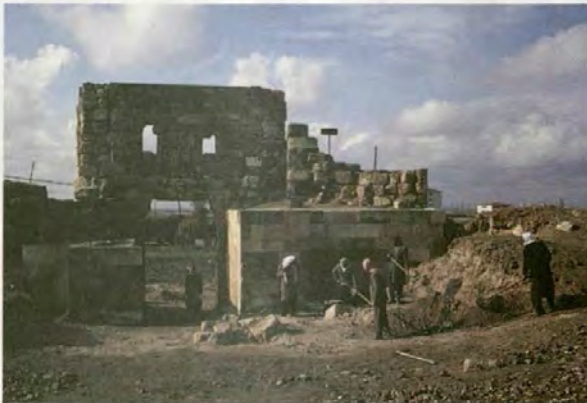
Resim 15 : Halep Kapısı'nın içten görünümü
