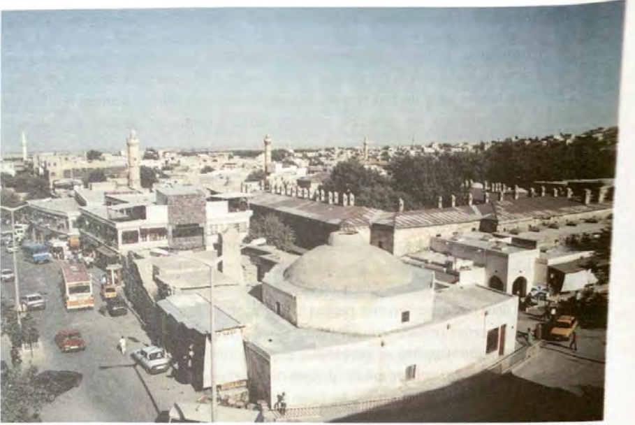
Resim 1 : Tarihi Çarşıların yer aldığı bölgede, Gümrük Hanı ile Arasa Hamamı bitişiğindeki tarihi han yıkılarak yerine yapılan iki katlı betonarme kuyumcular çarşısının görünümü
