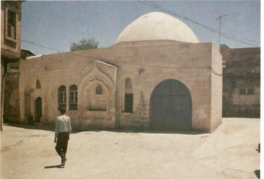
Resim 4 : Şeyh Saffet Çeşmesi ve Türbesi Restorasyon sonrası
