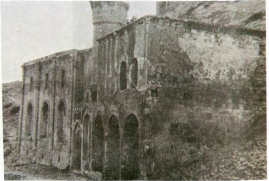
Resim 14 : Çarşı Camii, yıkılmadan önce (S.ERKEN'den)
