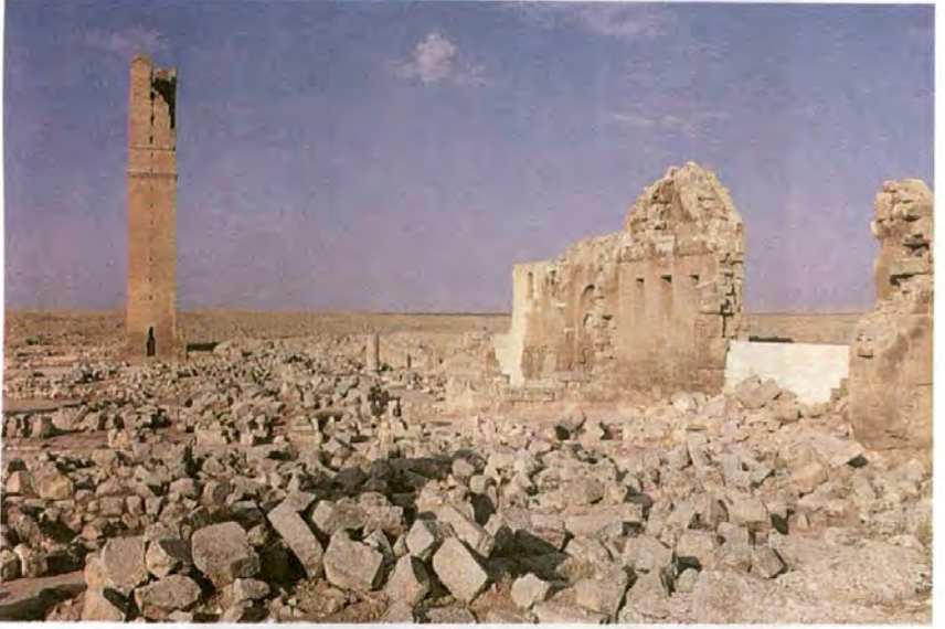
Resim 11 : Harran Ulu Camii ve restorasyon yapılan dođu duvarından genel görünüm
