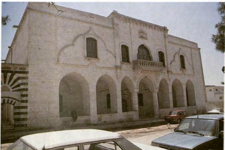
Resim 4 : Selahattin Eyyubi Camii, batı cephe
