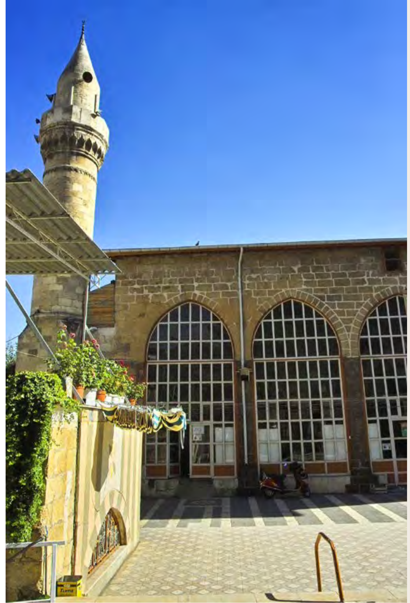
Şeyh Fethullah Camii
