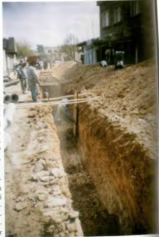
Akçakale Kanalizasyon ve Arıtma Tesisi İnşaatı
