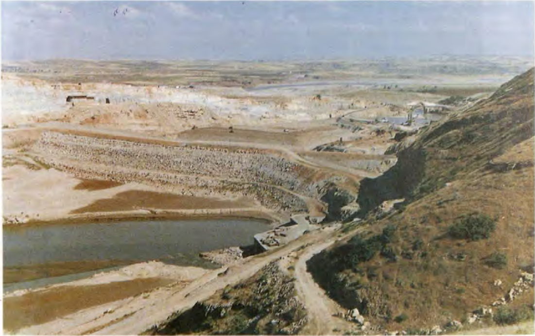
Batman Barajı İnşaatı
