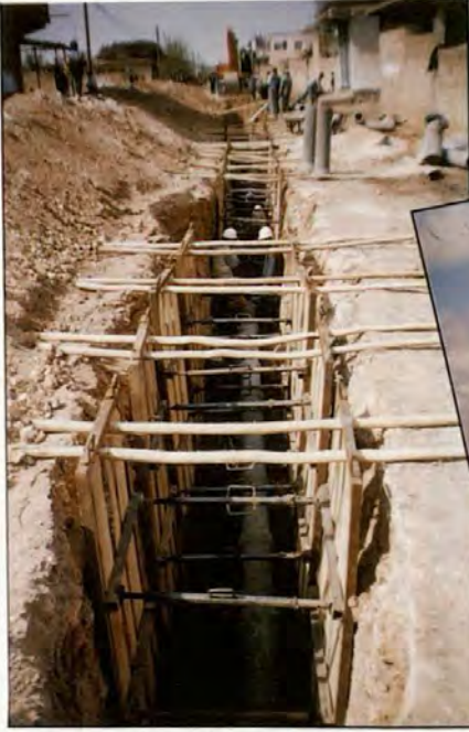
Ceylanpınar Kanalizasyon İnşaatı
