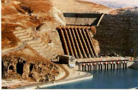
Atatürk Barajı Cebri Boruları
