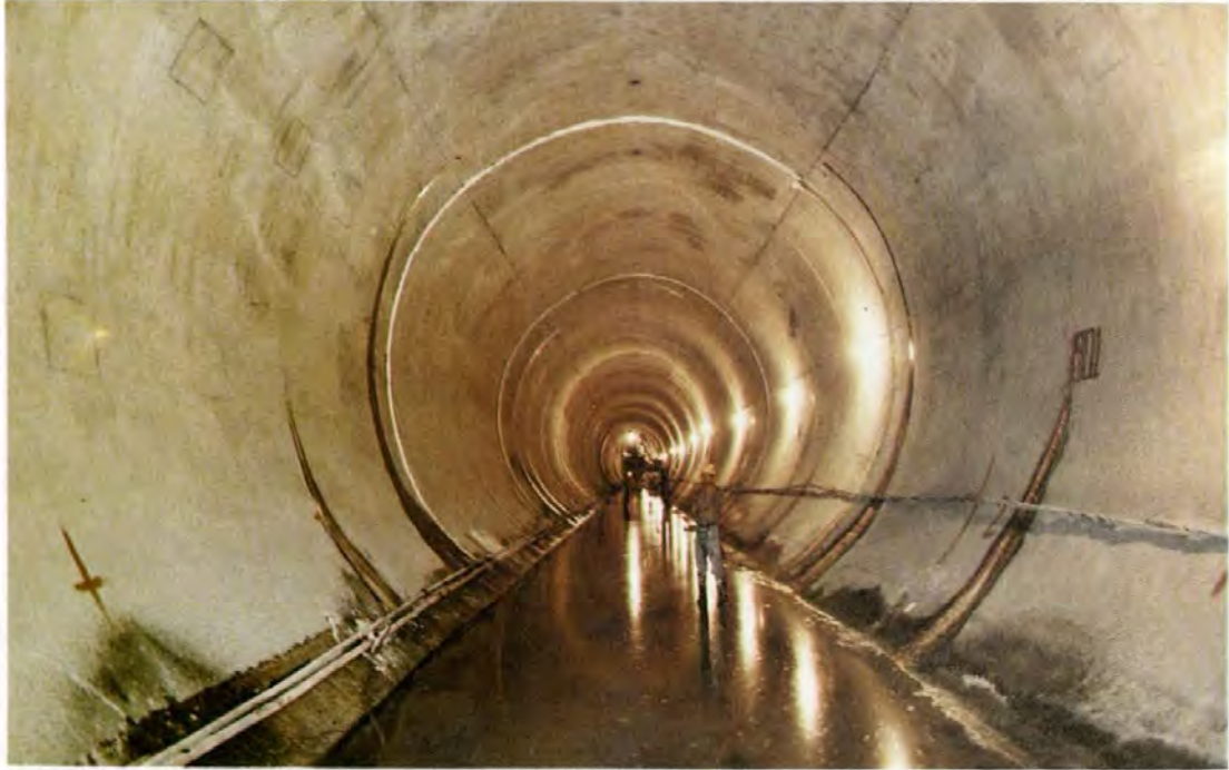
Şanlıurfa Sulama Tüneli
