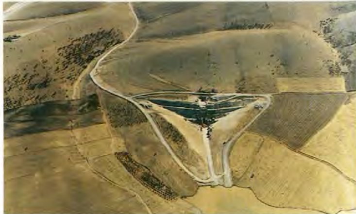
Suruç-Baziki Projesi Yaslıca Tüneli İnşaatı
