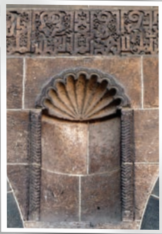
Diyarbakır Ulu Camii
